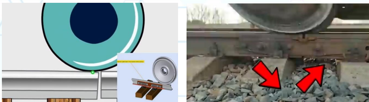
2-rasm. G'ildirak va rels chokining o'zaro birgalikda ishlashi.
