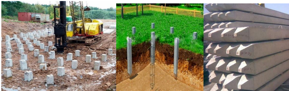
4-rasm. Qoziq poydevorlarni o‘rnatish.
