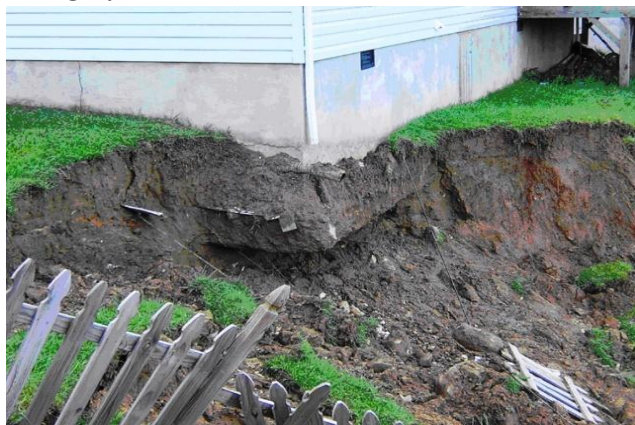
2-rasm. Gruntlarning doimiy bosim ta‘sirida vaqt davomida cho‘kishi.
