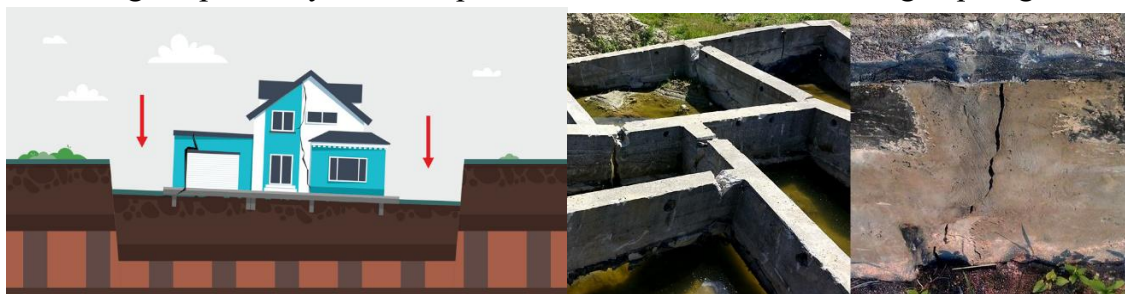
1-rasm. Gruntlarning bosim ta’sirida tabiiy cho‘kishi.
