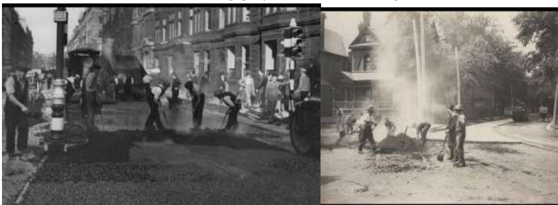
Birinchi asfaltbeton yotqizilish jarayoni.
