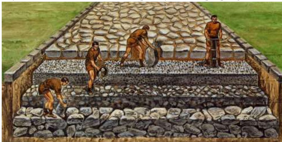
Mil.avv. 312-yilda qurilgan Via Appia yo‘lining qurilish jarayoni.
